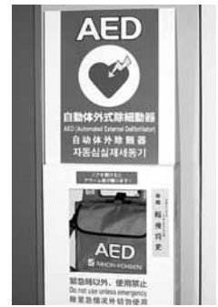
設置されたAED
